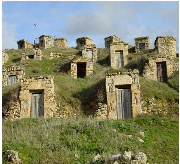
Figura 1. Conjunto de bodegas subterráneas en la localidad soriana de Aldea de San Esteban.
